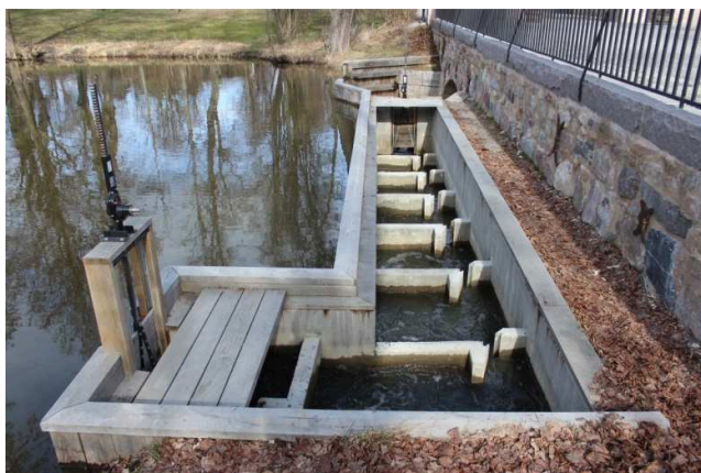
Figur 1. Genom att skapa en fiskväg i form av en slitsränna är det idag möjligt för fisk att vandra förbi Ulriksdals dämme. Foto: Rickard Gustafsson.
