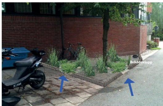
EFTER: REGNGÅRD Uppbyggnad av asfaltsyta. Regngård med släpp i kansten och bräddning till ny kupaibrunn.
