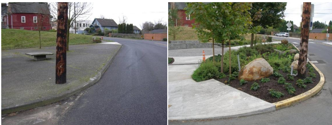
Figur 2 Före (vänster) och efter (höger) åtgärd för dagvattenhantering.
