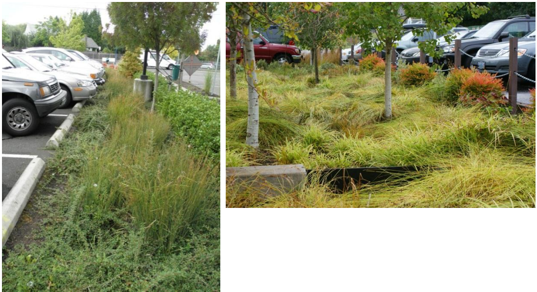
Figur 4: Parkeringsplatser där dagvattnet leds mot grönytor.
