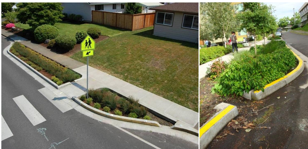
Figur 1 Utvidgad kantsten med plantering för omhändertagande av dagvatten.
