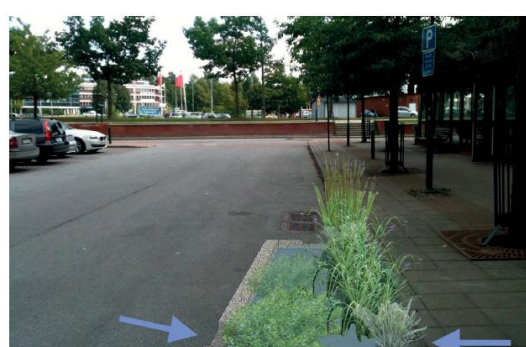
EFTER: UTVIDGAD KANTSTEN Ärsvattning av p-yta och gångbana vi släpp i kantsten. Utbopp till befintlig brunn i gata.
