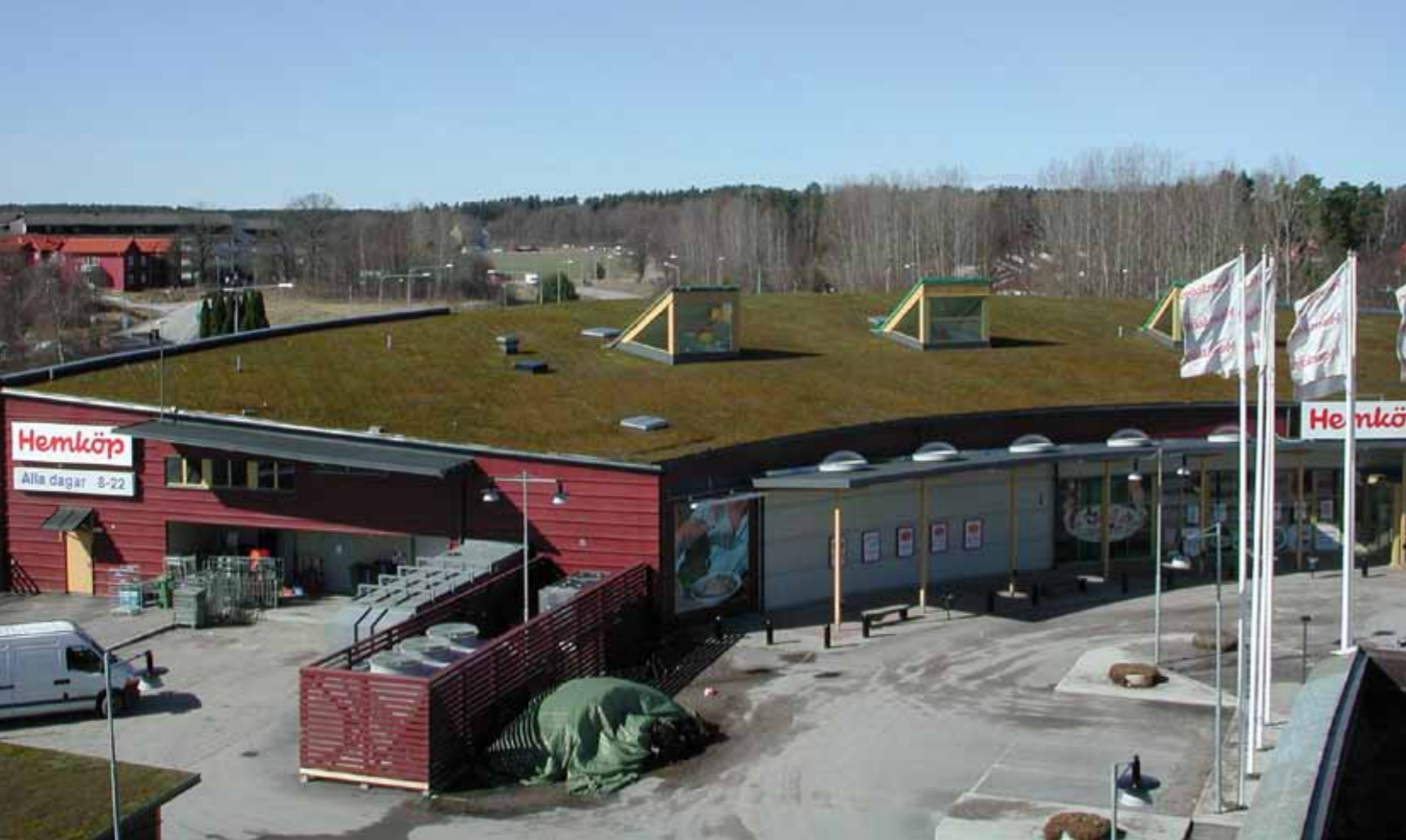
Sedumtak fördröjer regnvatten både på större och mindre byggnader (Upplands Väsby). Foto Andreas Jacobs
