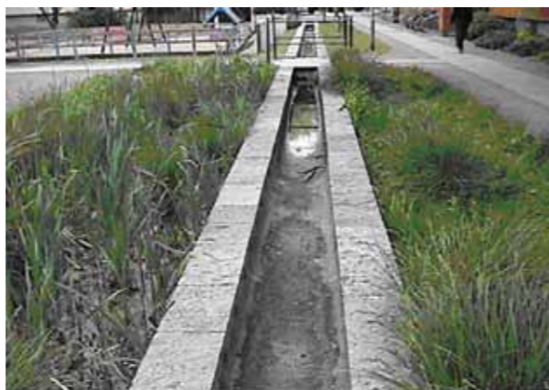
Dagvattenstråk med översilningfunktion och infiltration (Malmö). Foto Åke Ekström
