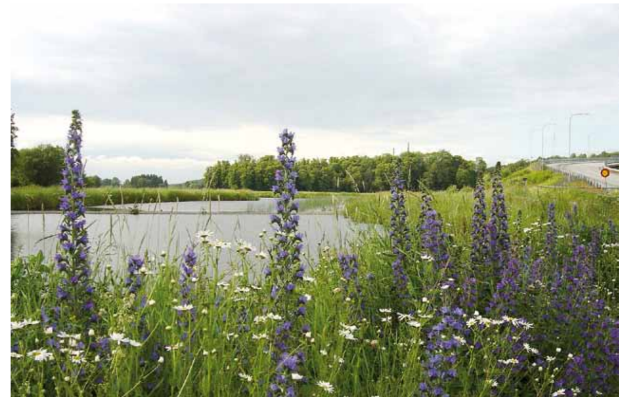
Anlagd damm i lantlig miljö (Upplands Väsby).
